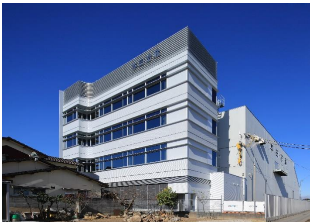
5) 事務所・冷蔵庫棟／2018
