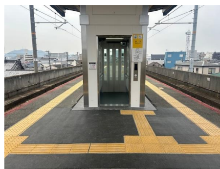
エレベーター設置（JR 播但線 京口駅）
