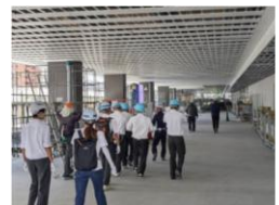
西宮総合医療センター建設現場見学会
