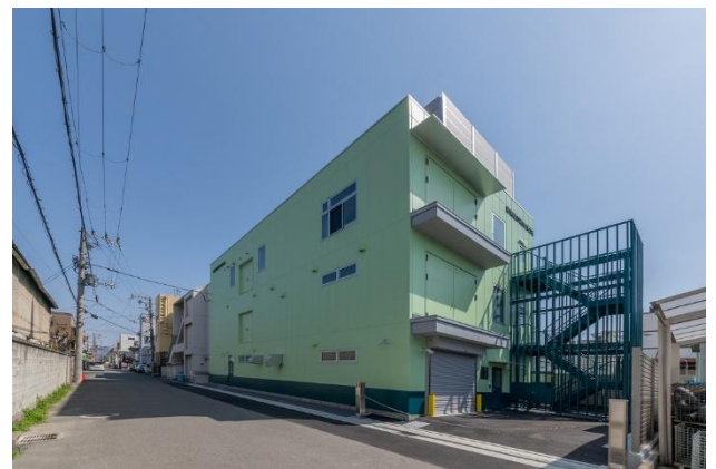
寿精版印刷 高井田工場
