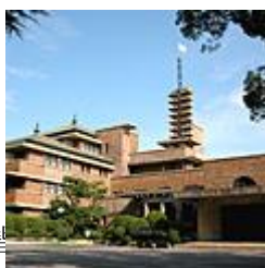
北西から見た客室棟と正面玄関
