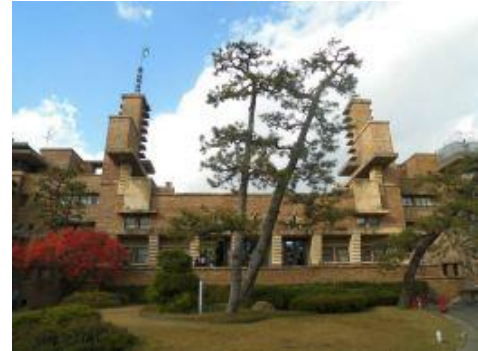
(旧客室棟 庭園から)
