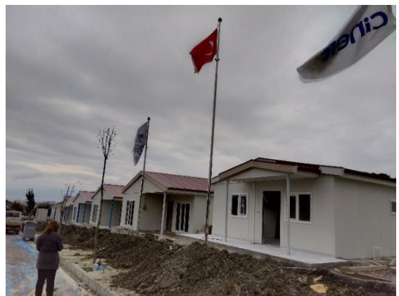
プレハブタイプの仮設住宅
