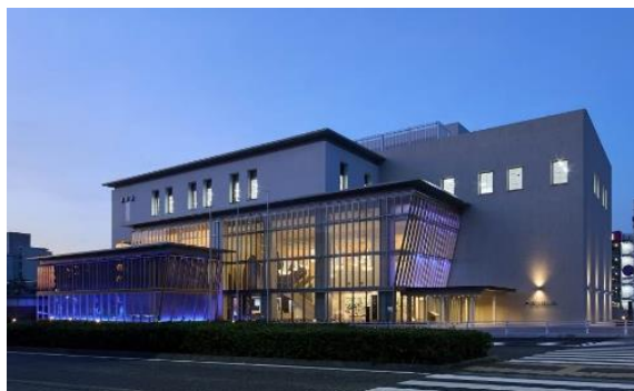
【ひょうごはじまり館 (R4.9月竣工)】
