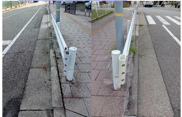
写真一〇 シリコン塗料を隙間に施工した直後
