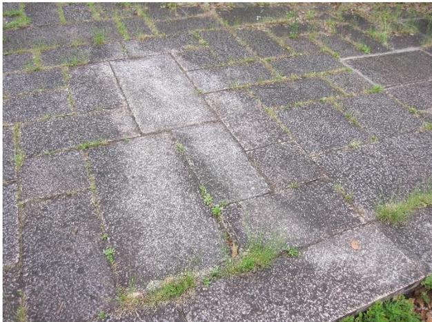
写真一三 熱湯除草後シリコン塗料を施した箇所
