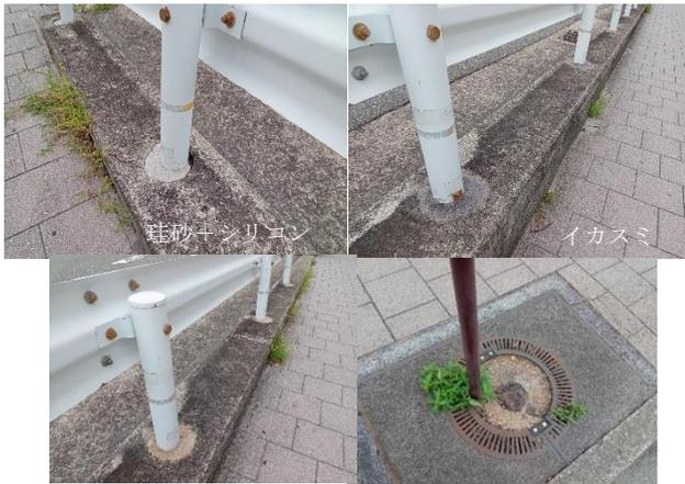
写真一11 3月に施工したガードレール基礎部等に防草措置を施した箇所の様子
