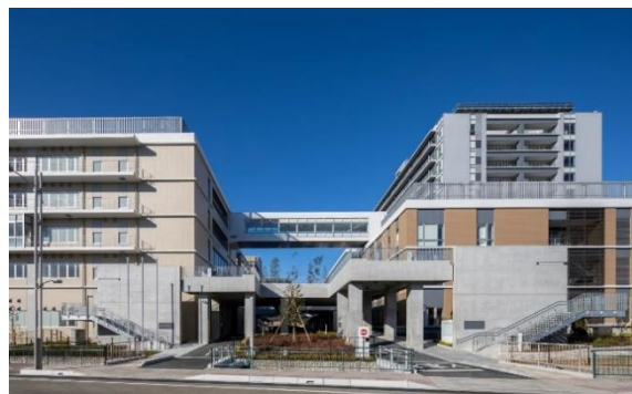
【 R3.11 竣工 兵庫県立はりま姫路総合医療センター 】
