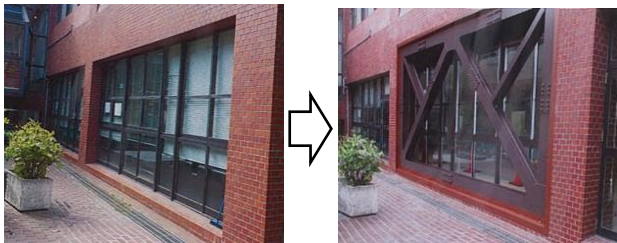
【ブレース補強による改修工事】
