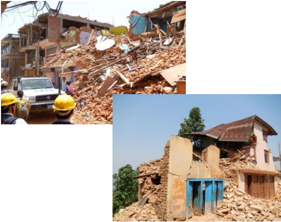
(ネパール地震被災地の代表的な建築物)
