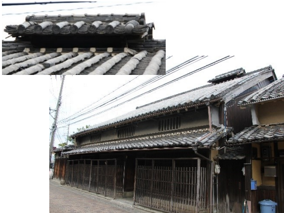
ひめぢ道黒田商店の向かいの古民家の 越屋根：煙だしに屋根をまたいで一段高 く設けた小屋根
