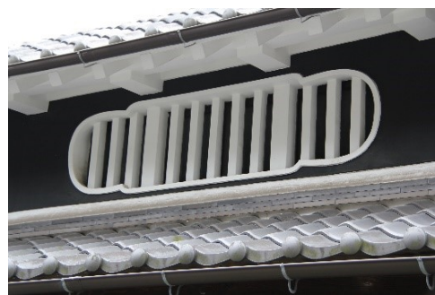
虫籠窓（稲見酒造前の古民家）：中二階 の換気窓、配列、意匠に左官職人の技術
