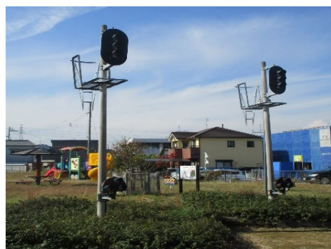
三木駅には場内信号機の遺構が残る。
