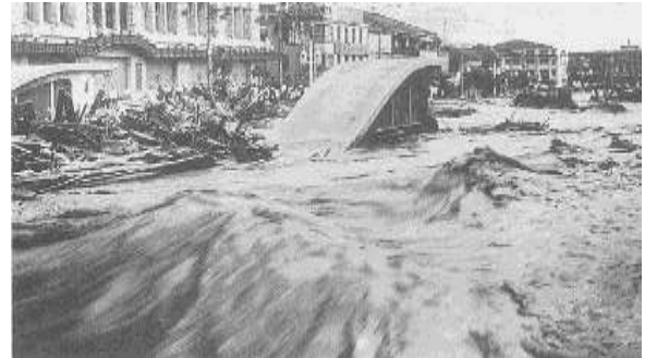
昭和13年の阪神大水害をも経験した、地下道入口
