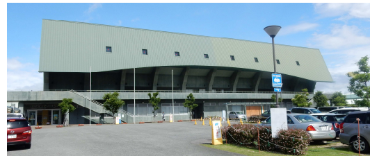
尼崎21世紀の森中央緑地・プール
