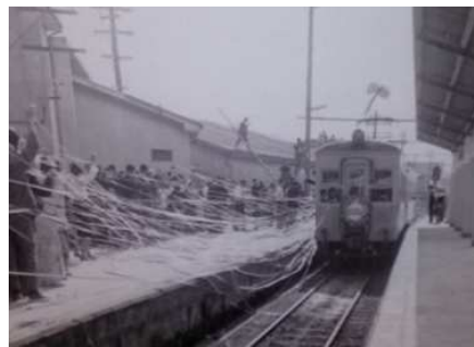
さよなら運転の様子(洲本駅)
