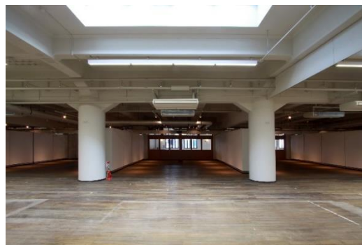
新館 1階展示スペース 全面的床部分液状化対策コンクリート壁増設、柱補強、床・壁・天井改修工事
