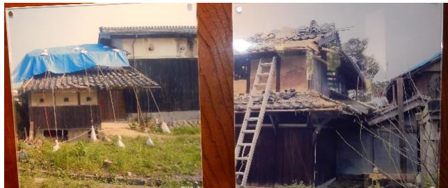
展示されている改修状況写真
