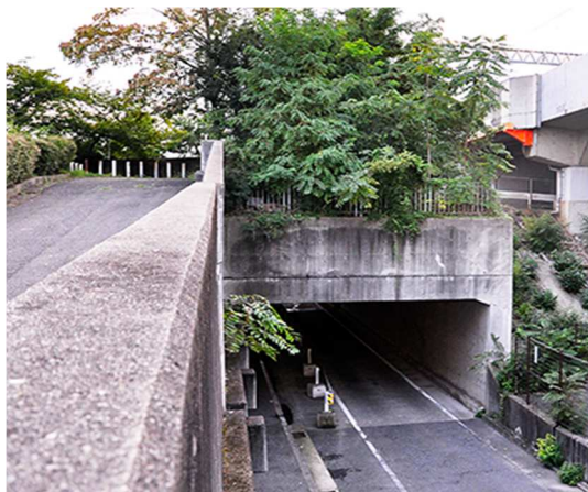
石屋川トンネル
