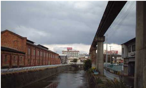
船場川とモノレール軌道の遺構
