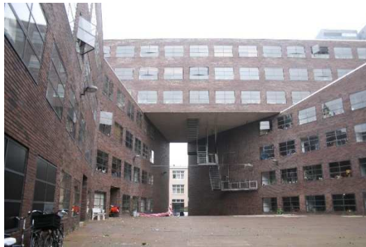
▲ 集合住宅ピラエウス
