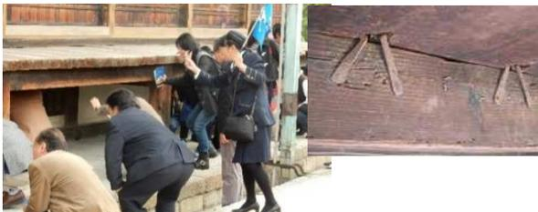
二条鶯張りの仕組み: 二条城といえば廊下の鶯張り。見学中、ずっと「ピュッピュッ」との鳴き声で賑やかである。これは、床板を踏むと「目かすがい」が上下し、「目かすがい」と「釘」が擦れ合い音がするとのこと。写真は仕組みを観察中。
