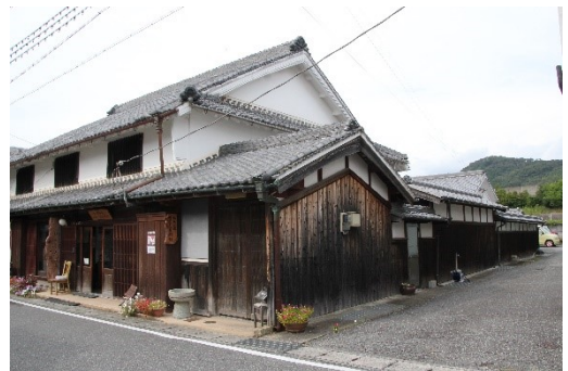
水田家住宅（西北向きの景観・奥行きが深さがよく分かる）
