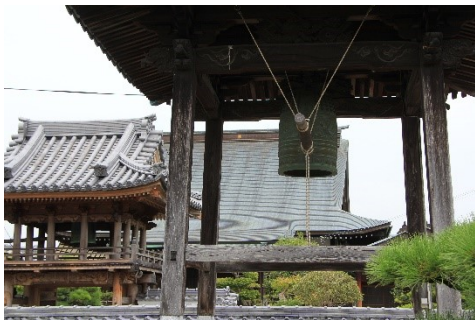
大信寺鐘楼から西岸寺鐘楼、本殿を望む
